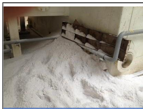
冷箱角部、结构开裂和渗漏 珠光砂泄漏
