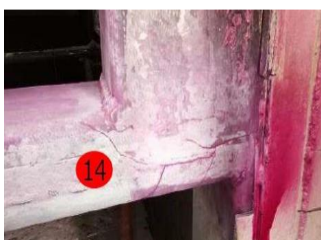
冷箱角部、结构开裂和渗漏 珠光砂泄漏
